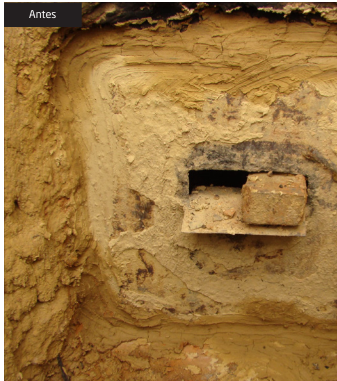
Antes Entrada de oxigênio (vedação com tijolo e argila)
