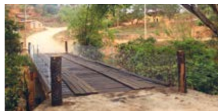
A ponte foi construída com madeira doada pela Aperam BioEnergia
